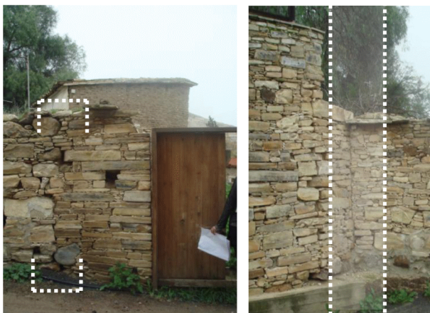
ΔΙΑΦΟΡΟΠΟΙΗΣΗ ΤΩΝ ΟΨΕΩΝ ΚΑΘΕ ΙΔΙΟΚΤΗΣΙΑΣ ΜΕ ΔΙΑΦΟΡΕΤΙΚΟ ΤΡΟΠΟ ΚΑΤΑΣΚΕΥΗΣ ΤΗΣ ΤΟΙΧΟΠΟΙΑΣ ΚΑΙ ΜΕ ΤΟΥΣ ΓΩΝΙΟΛΙΘΟΥΣ.
