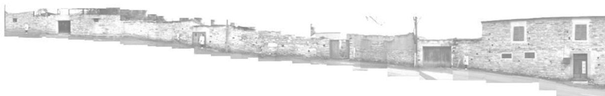
ΔΙΑΦΟΡΟΠΟΙΗΣΗ ΤΩΝ ΟΨΕΩΝ ΚΑΘΕ ΙΔΙΟΚΤΗΣΙΑΣ ΜΕ ΔΙΑΦΟΡΕΤΙΚΟ ΤΡΟΠΟ ΚΑΤΑΣΚΕΥΗΣ ΤΗΣ ΤΟΙΧΟΠΟΙΑΣ ΚΑΙ ΜΕ ΤΟΥΣ ΓΩΝΙΟΛΙΘΟΥΣ.
